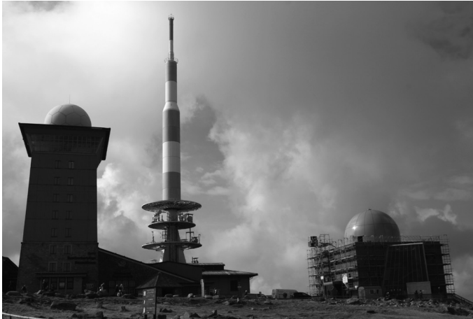
Abb. 3. Diverse Installationen auf dem Brockengipfel; Foto: J. P. September 2017
